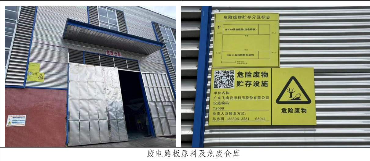
图4.2-3 本项目危险废物贮存场所
