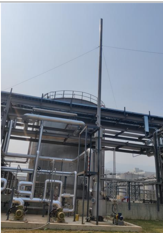
酚醛树脂、脲醛树脂废气处理设施（二级洗气塔）
