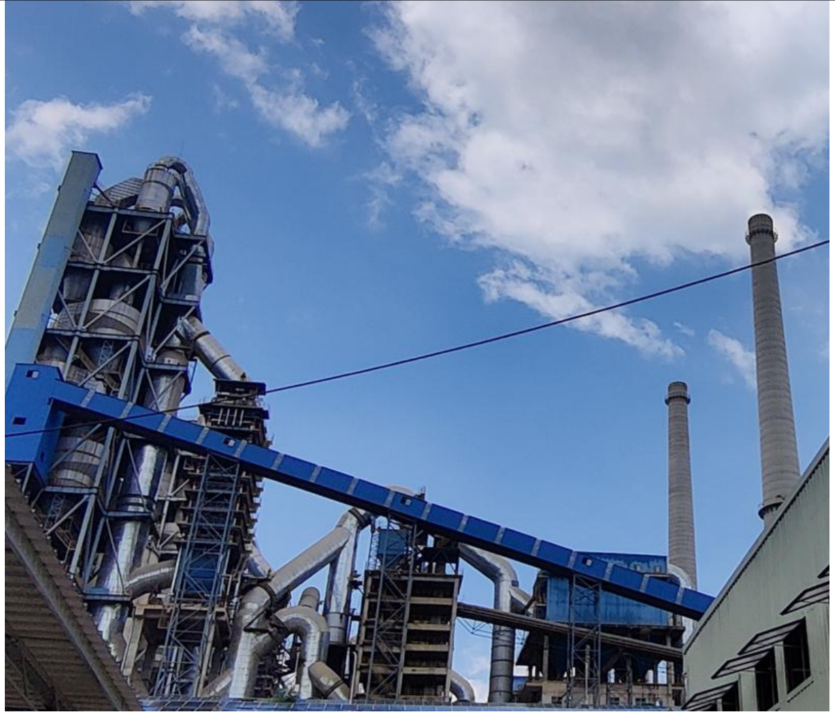
窑尾废气排气筒（5#、6#窑）
