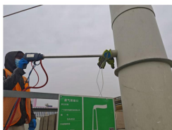
污水处理站废气排放口 (DA067)
