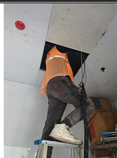
食堂油烟废气排放口
