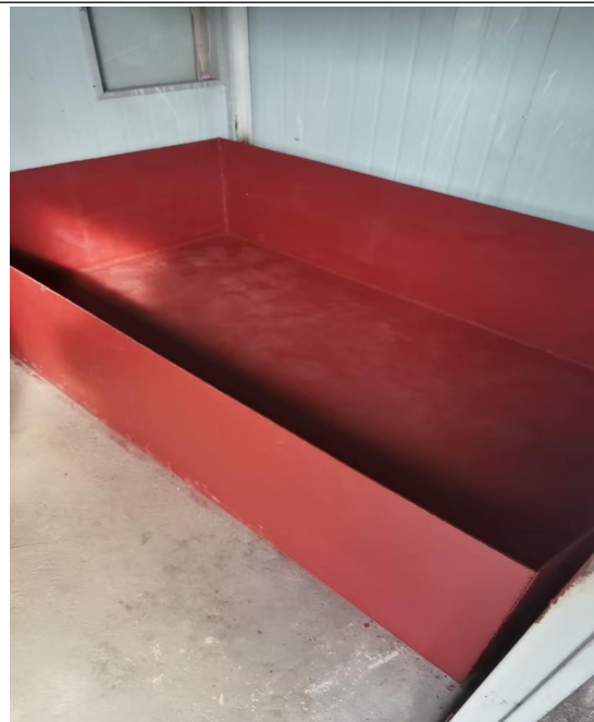
油漆存放点、天那水存放点
