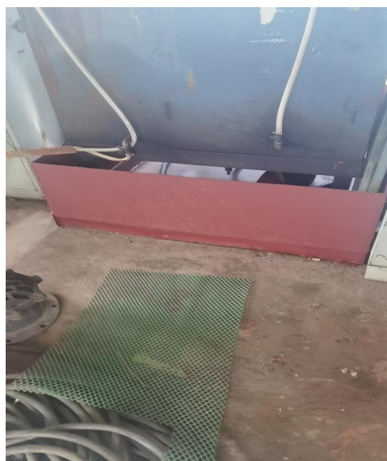
备用发电机柴油箱及围堰
