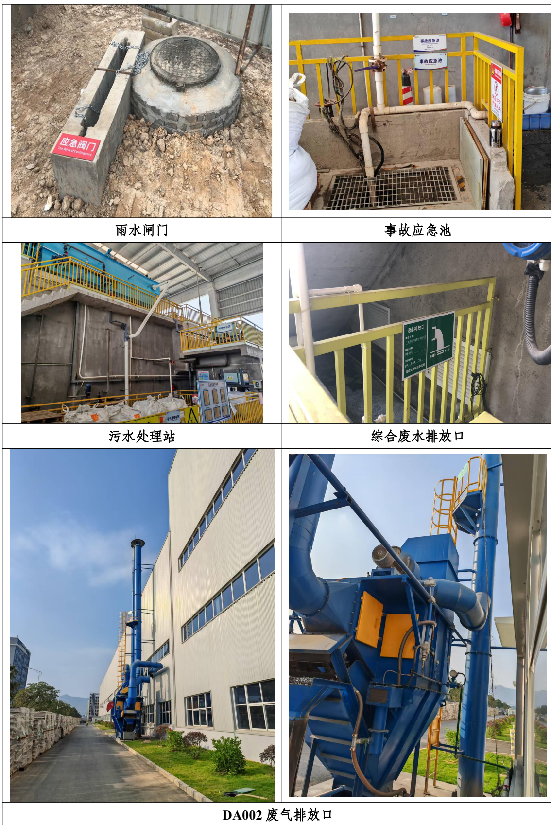
附图 4：项目设施现场图片
