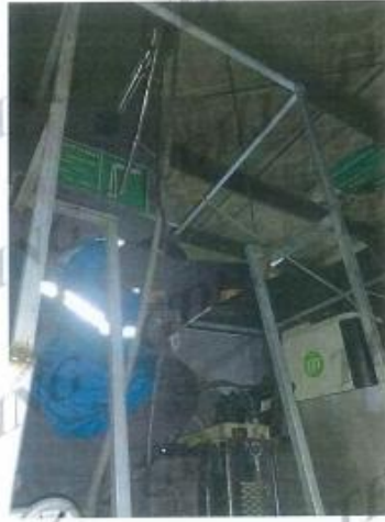
C2 车间氧化生产线酸雾废气排气筒
