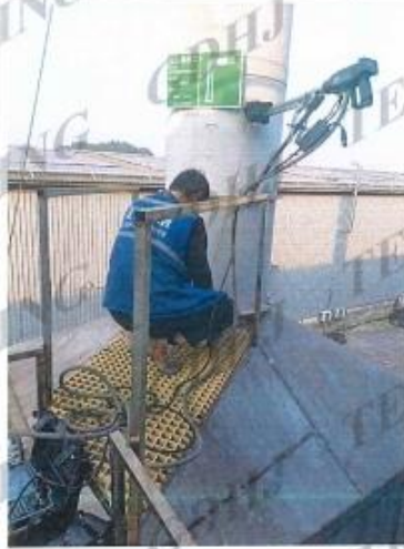
B6 车间电泳生产线酸雾废气排气筒
