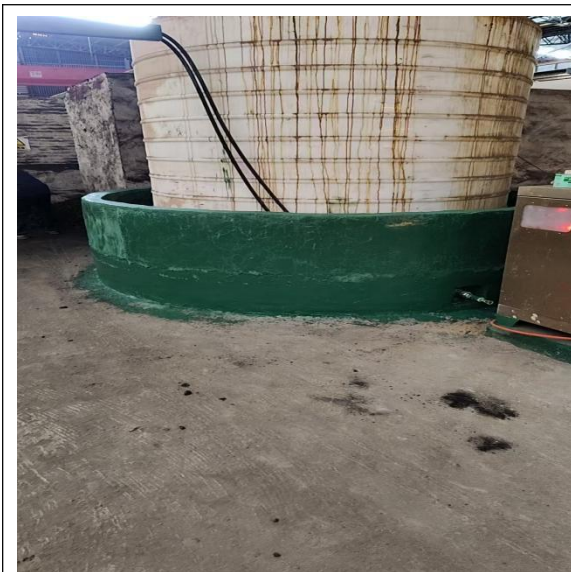
氨水储罐围堰
