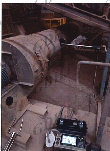
制砖生产线粉尘排放口 DA003
