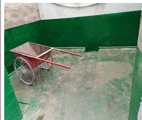
危废暂存点防渗防漏措施
