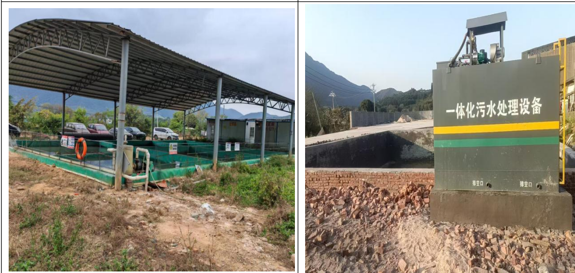
喷淋塔循环水池
