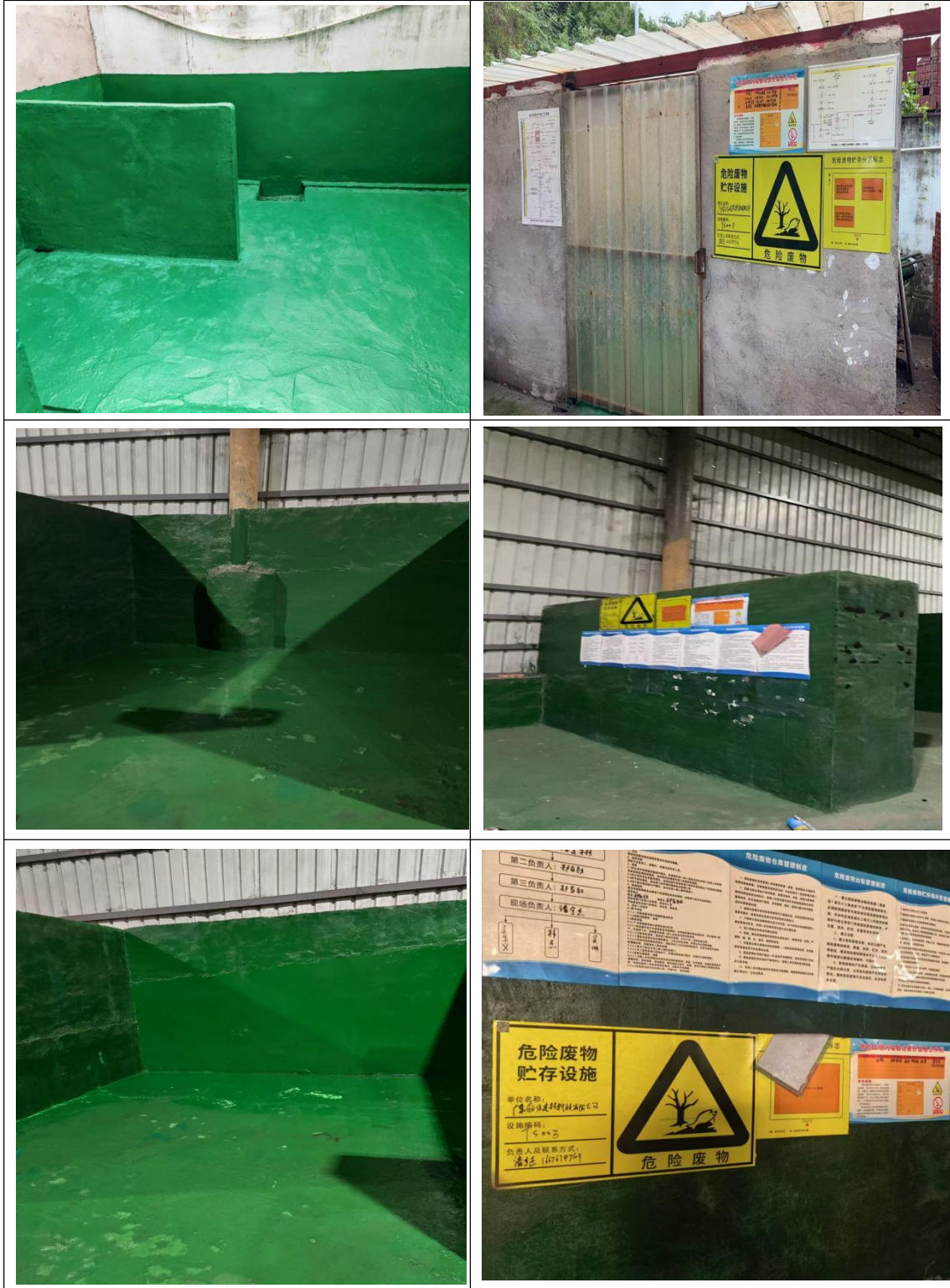
图 4.1-8 危险废物仓库现场图
