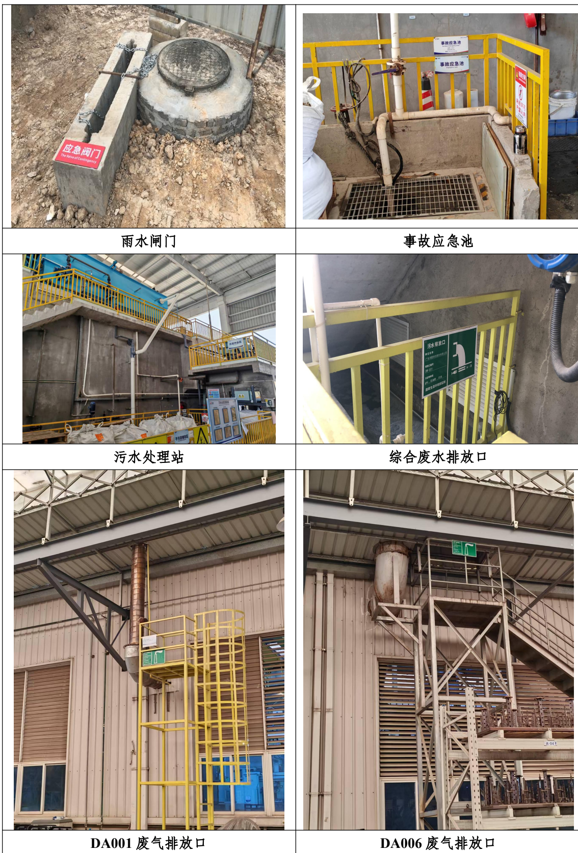
附图 4：项目设施现场图片
