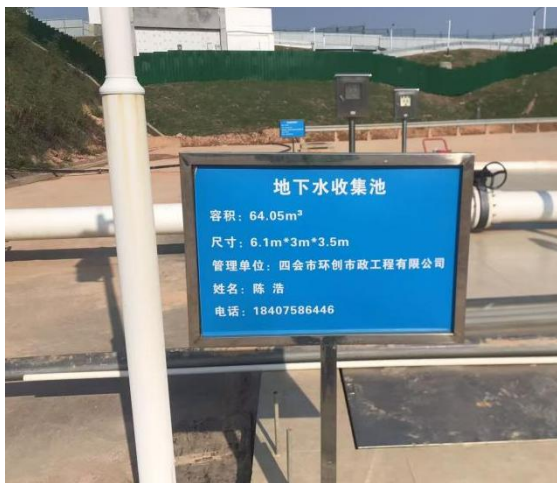
地下水收集池 标识牌
