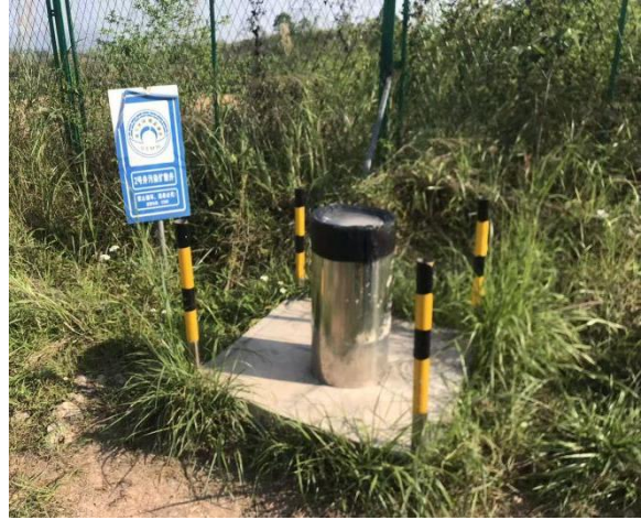
地下水监测井（污染扩散井1）
