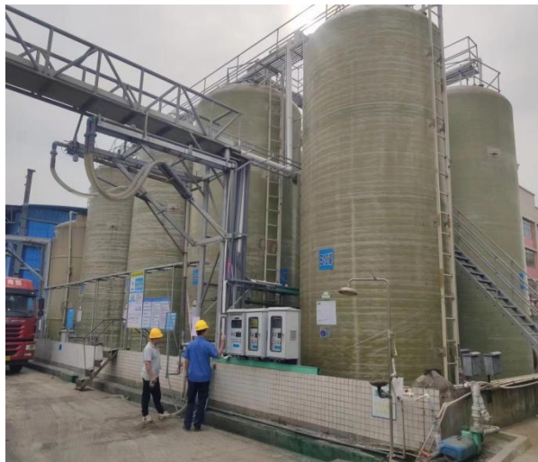
新设储罐区2#储罐16个及围堰
