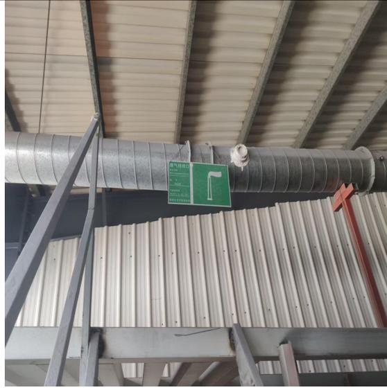
E3 喷粉车间固化废气采样口
