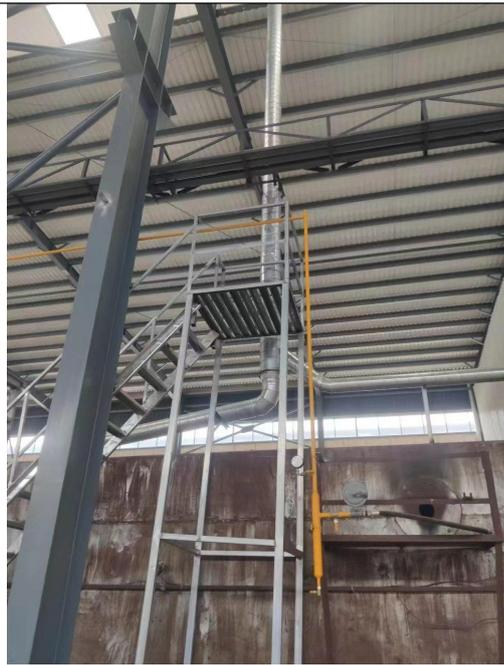
B1 挤压和时效炉燃烧废气排放口的采样口及平台
