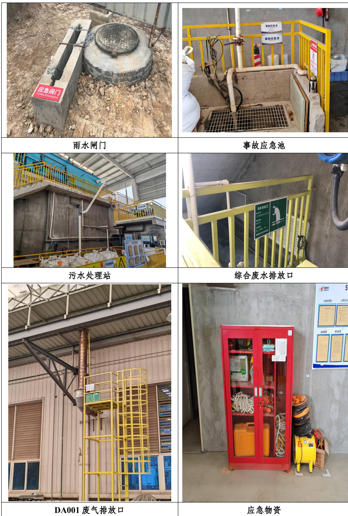
附图 4：项目设施现场图片
