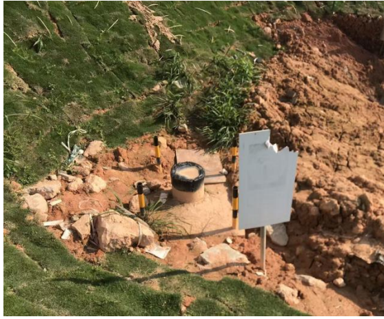
地下水监测井（污染监视井2）
