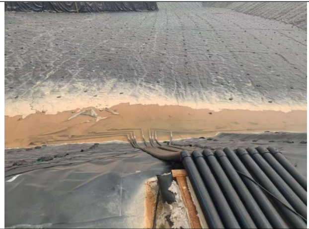
雨水抽拍管网
