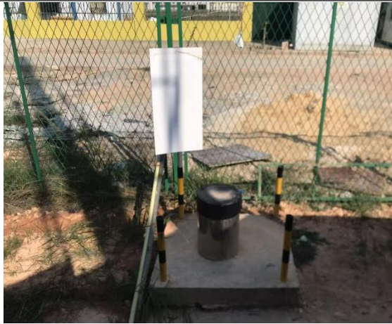
地下水监测井（污染扩散井2）
