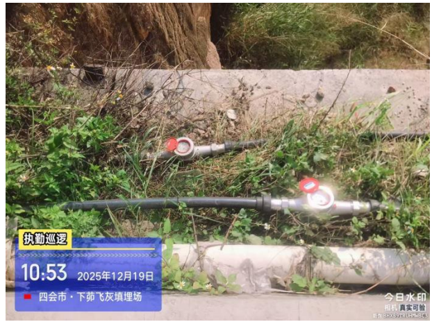
淋溶液输送管道及水表
